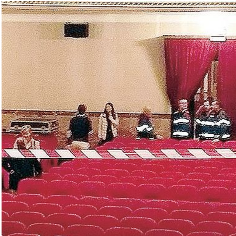
Sempre più tesi i rapporti tra proprietà e amministrazione comunale dopo il crollo del controsoffitto
