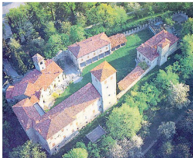
Una panoramica del castello di Montegibbio
