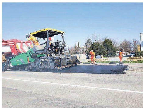
La riasfaltatura per coprire le buche stradali sulla Pedemontana
