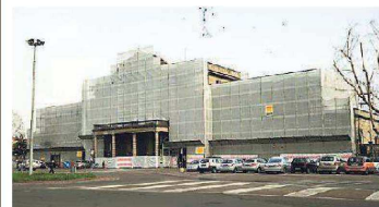
La Stazione piccola "impacchettata" per i lavori
