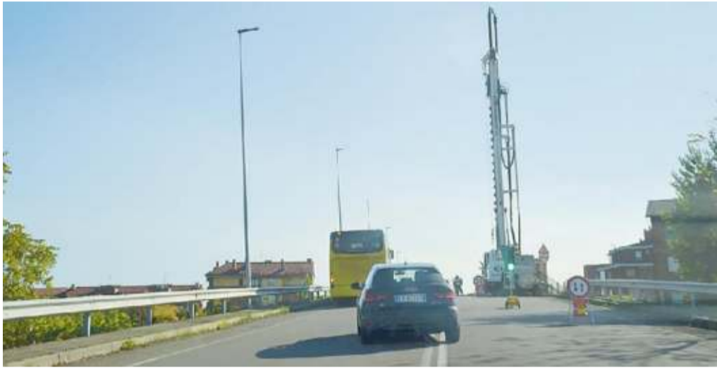
Il cantiere per il consolidamento del ponte Giovanni Da Verazzano
